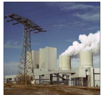
Das Braunkohlekraftwerk Lippendorf
